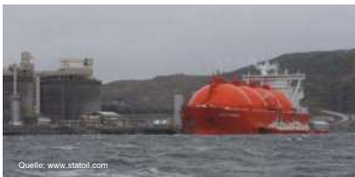
Erdgasindustrie (LNG Chain)
